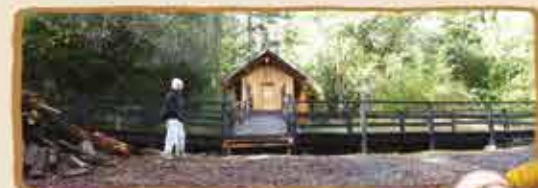
Panorámica de la construcción
